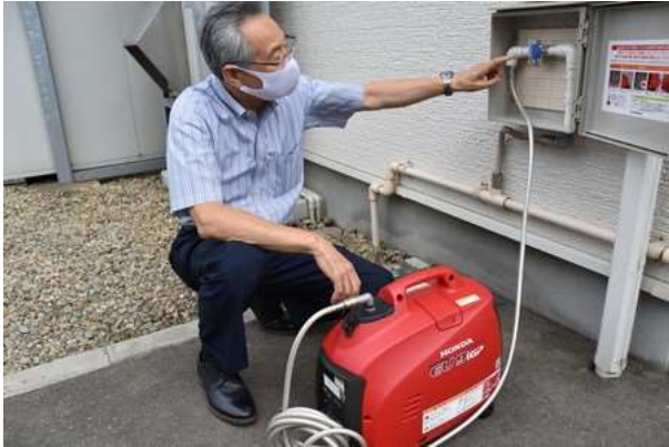
LPガス発電機とガス配管をつなぎ、始動手順を説明する障害者就労継続支援施設「Onememory」の沢田修明さん=8月18日、秋田市
